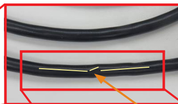
ケーブル被覆が変形
